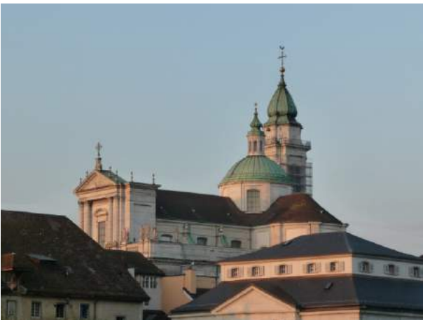
Und noch grösser wirkt das Gebäude aus der Nahdistanz
